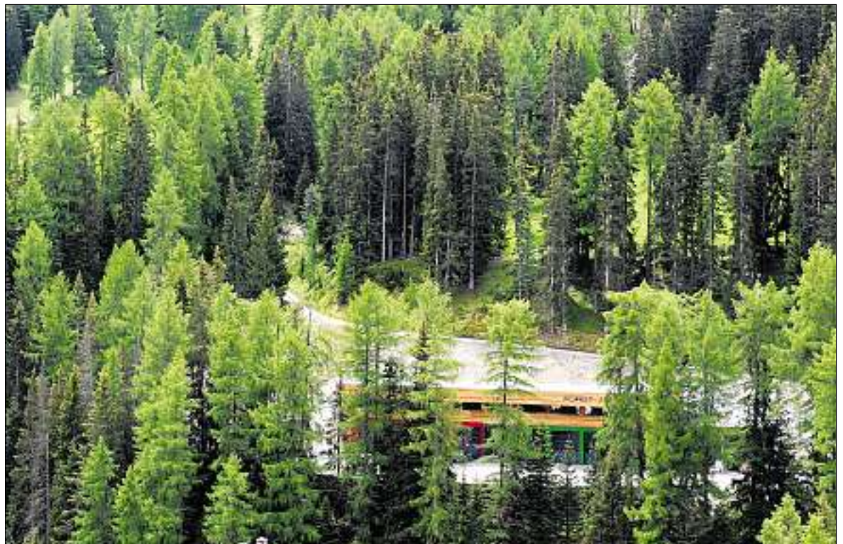
Mitten im Lärchenwald ein Gebäude aus Lärchenholz: der neue Forst-/Werkhof mit Feuerwehrhalle der Gemeinde Samnaun. (Foto Marco Hartmann)
